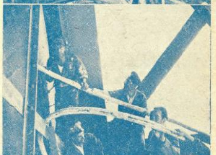
Colocação dum novo cabo na ponte de D. Luís I
