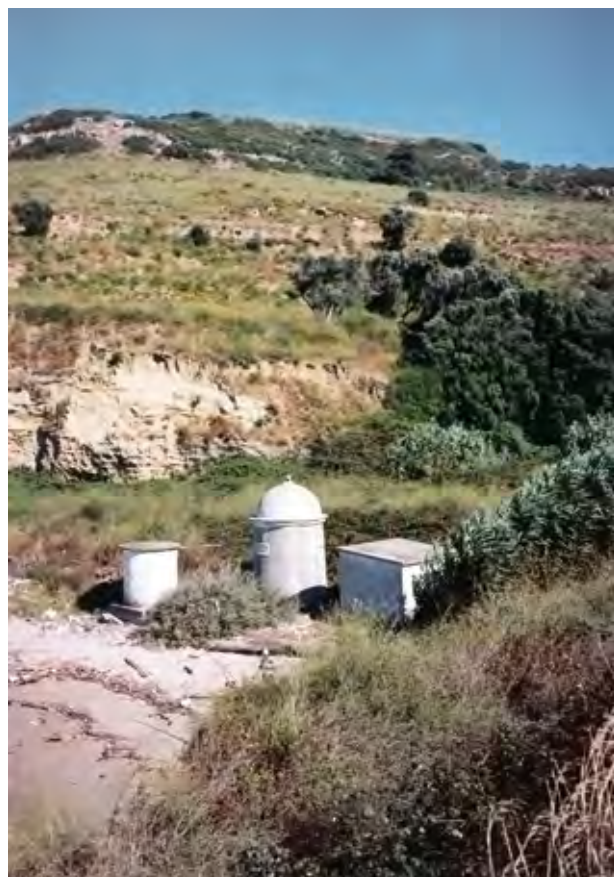
Edifício de amarração de cabos do Portinho da Costa.
